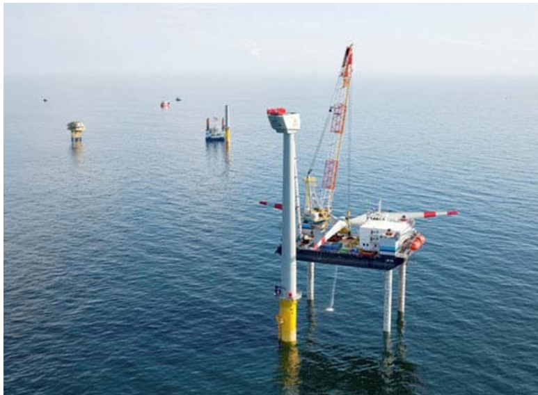
Abbildung 19 Jack-up barge im Offshore-Windpark „Alpha Ventus“ [MarineLog 2009]
